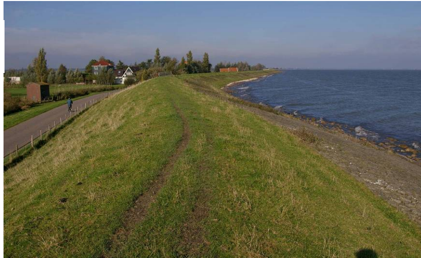
Foto 3.6 Talud met schapengaas en met steenbekleding aan de buitenzijde
