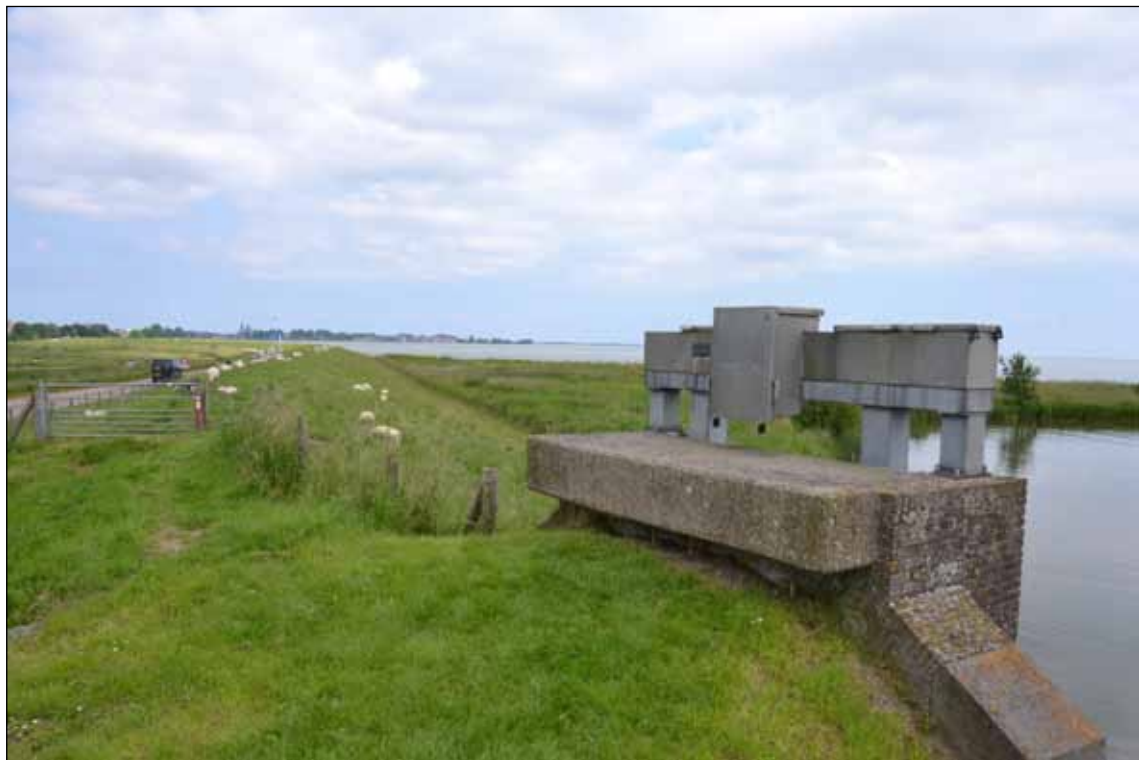
Afb. 9.12 Een deel van het 19 de -eeuwse stoomgemaal Westerkogge, gezien richting het noordoosten.
