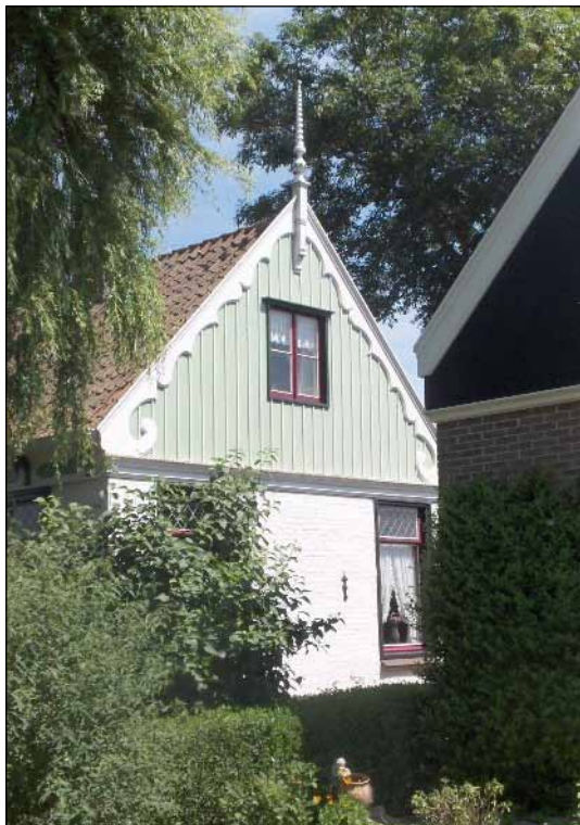
Afb. 9.37 Uitdammer Dorpsstraat 17, één van de weinige originele woonhuizen van kort na de watersnoodramp van 1916.
