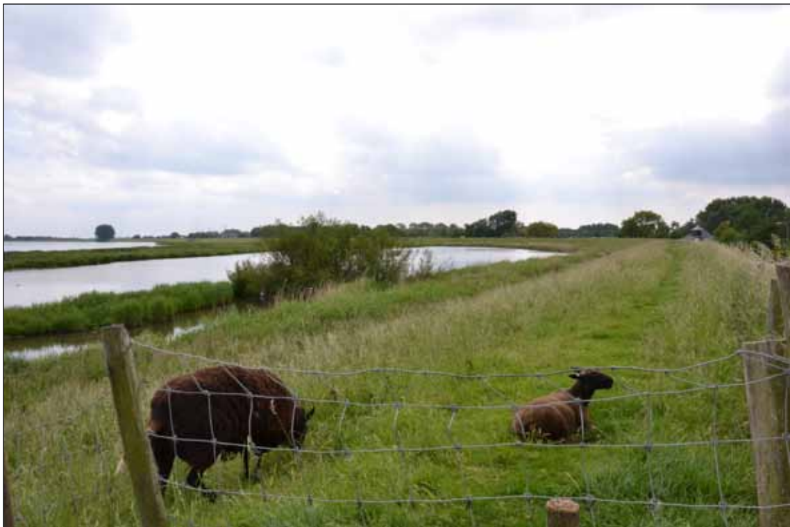
Afb. 9.2 Het buitenlandse land bij de Hulk, in de bocht van de Westerdijk. Gezien richting het zuiden.
