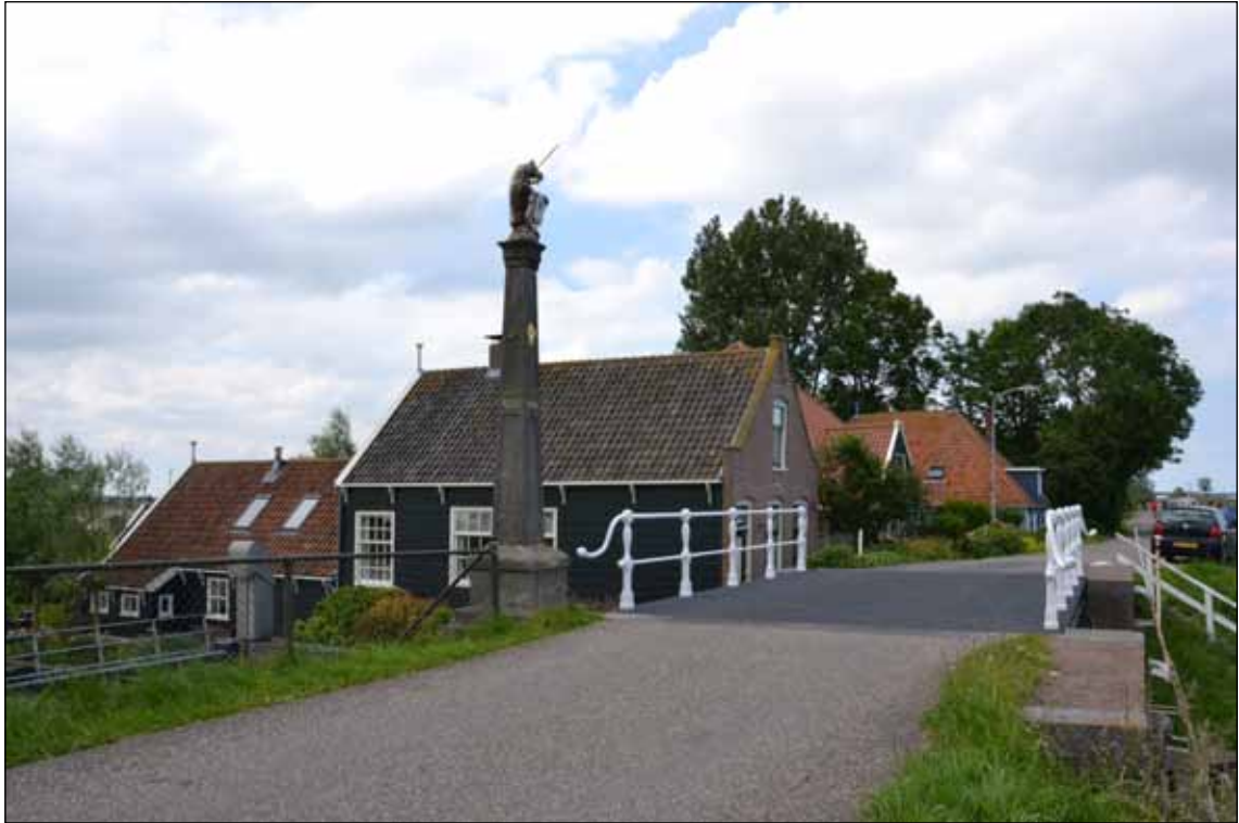
Afb. 9.13 Het sluisencomplex in Schardam met de banpaal uit 1761. Gezien richting het noorden.
