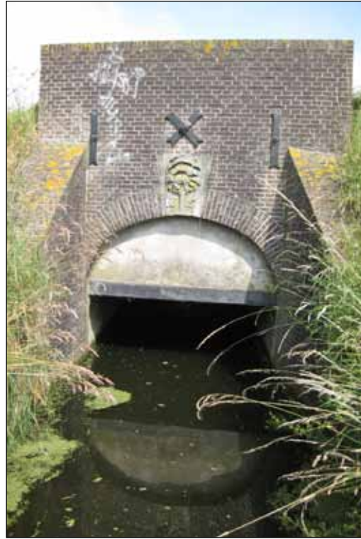
Afb. 9.18 De Kathammer uitwateringssluit uit de 17 de eeuw.
