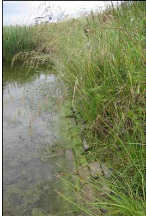
Afb. 9.30 Delen van de Nespolder worden beschermd door kades.
