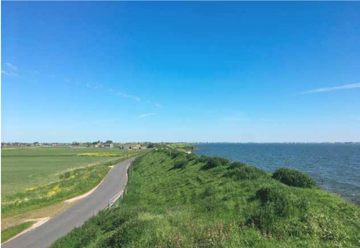
Aanleiding voor het KROK is tweeledig: de dijkversterking en de wens om de dijkzone te verbreden en een kwaliteitsimpuls te geven (foto: H+N+S. Zie uitgebreide bronvermelding achterin)
