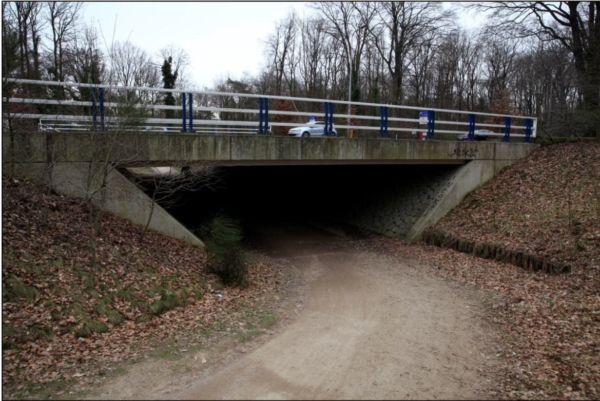
Figuur 5.1 De bestaande tunnel nabij restaurant La Place voor fietsers, wandelaars, ruiters en aanspanningen.
