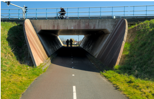
Fietstunnel N244 - N247 Edam
