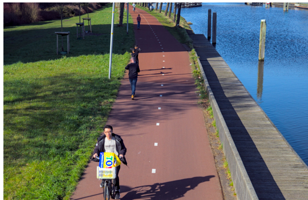
Fietspad Kanaalweg, Purmerend
