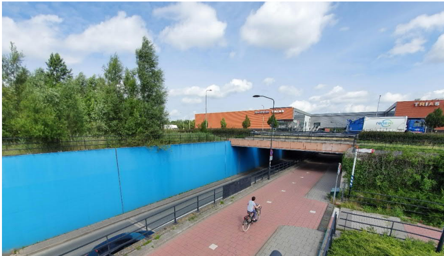
De Jan Brassertunnel, gezien vanuit Saendelft, met zich op het Trias VMBO
