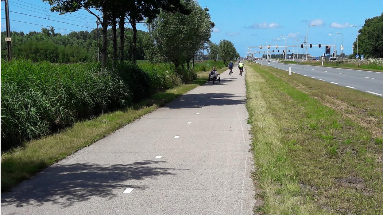
Figuur 4.6: Fietspad van betonplaten langs de N203
