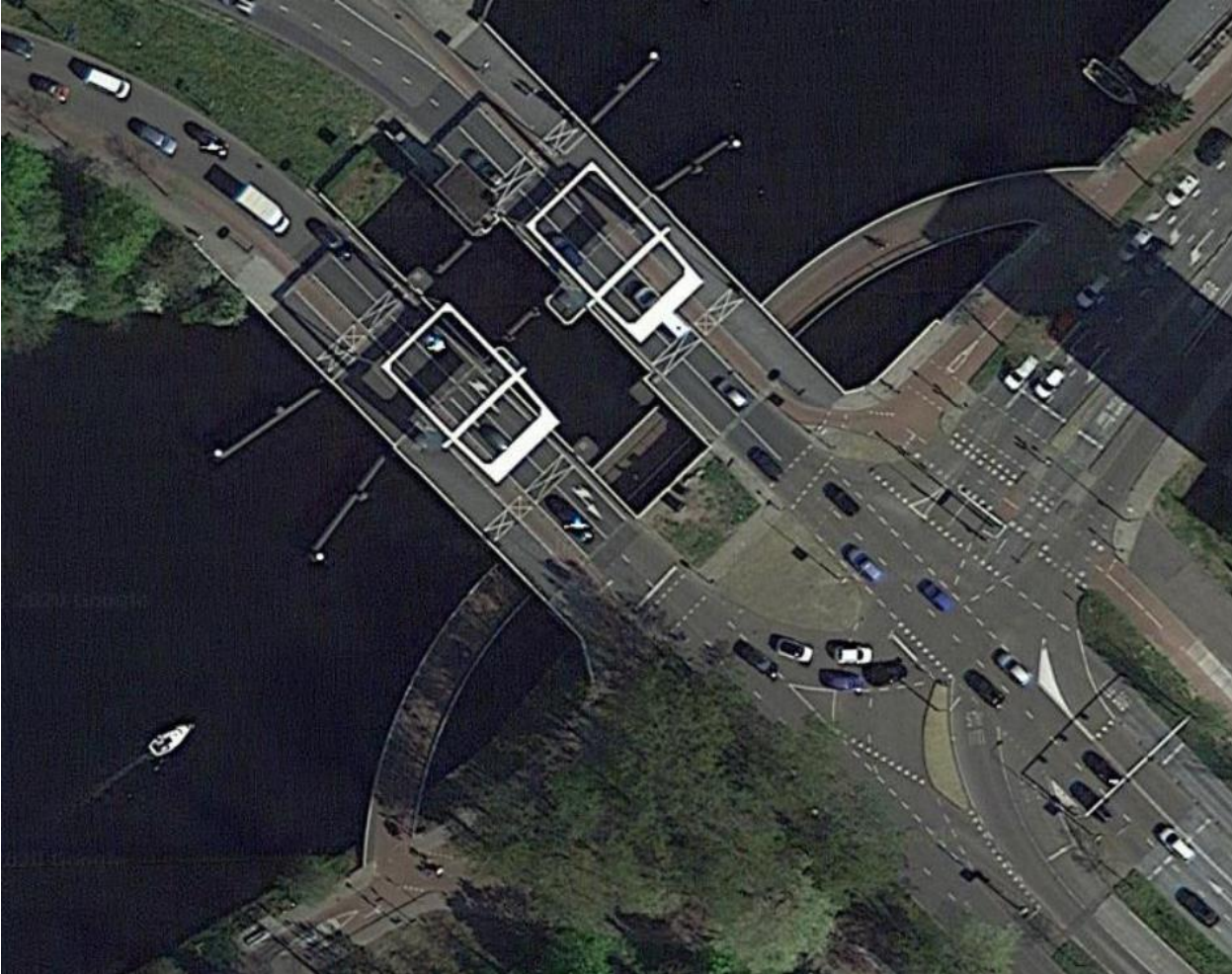
Figuur 4.3 Fietsroute in het water bij de Buitenrustbrug in Haarlem
