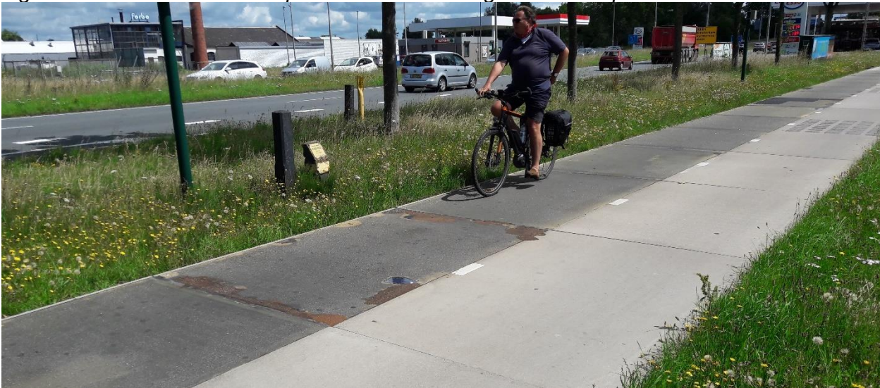
Figuur 4.5: Solaroad: zonnepanelen als verharding van het fietspad in Krommenie
