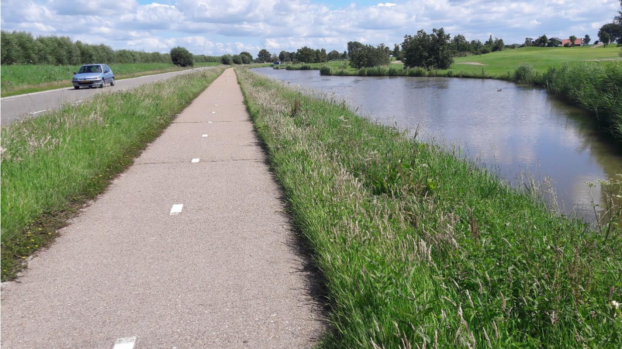
Figuur 4.7: Betonplaten Communicatieweg ter hoogte van de golfbaan
