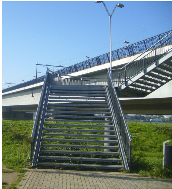
Afbeelding 4.1. Principeoplossing trap en fietsgoot (bron: fietsberaad)
