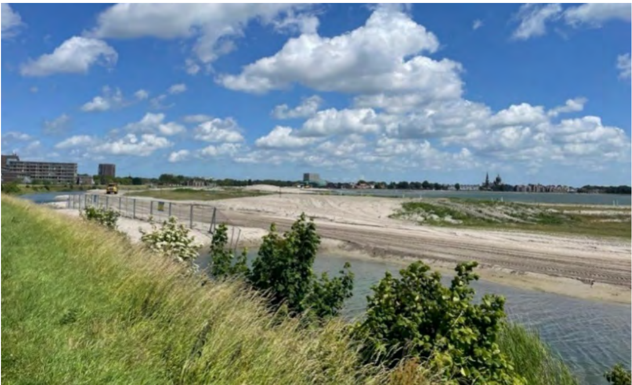
Foto 1 Aanleg nieuwe stadsstrand Hoorn, 2022
