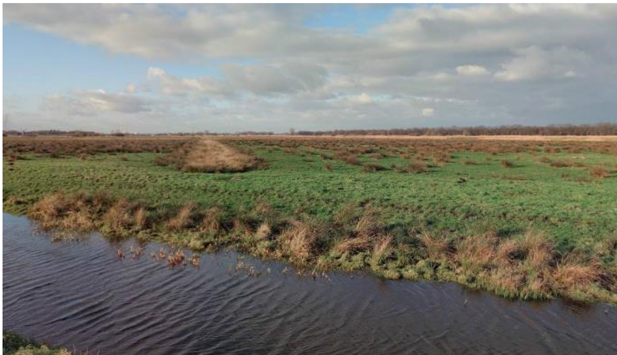
Figuur 4.2.4.3 Huidige situatie aan te passen watergang
