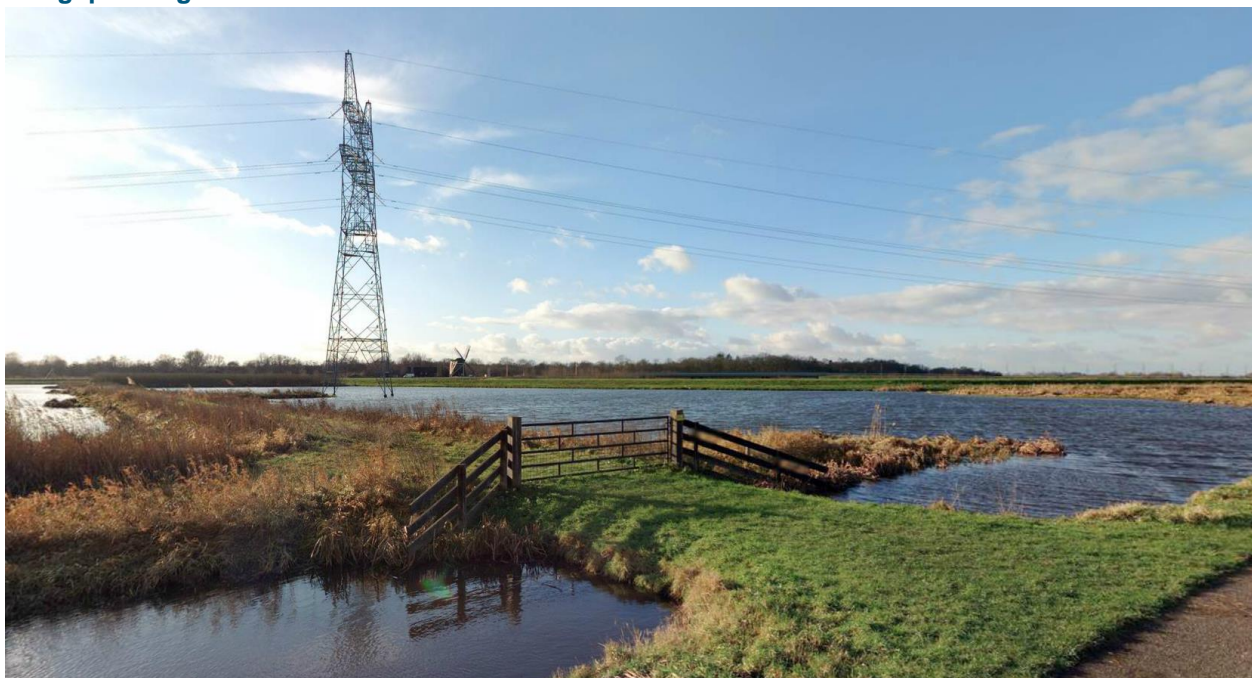
Figuur 3.6.5 Hoogspanningsmast in de Hilversumse Bovenmeent, bereikbaar vanaf de Melkmeent
