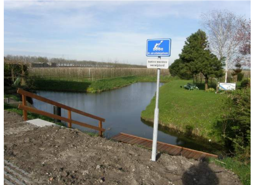
Kano uitstapplaats met betonnen trap.
