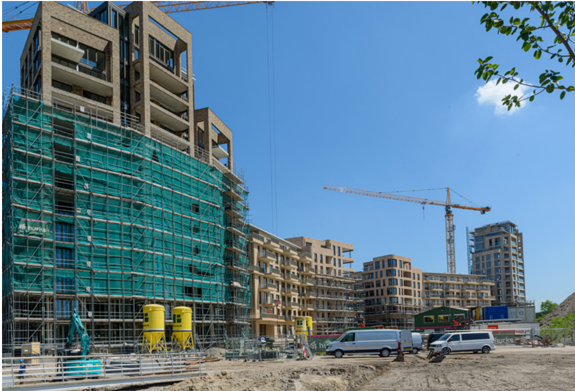
Afbeelding 1. Nieuwbouwwoningen nabij OV-knooppunt Diemen-Zuid
