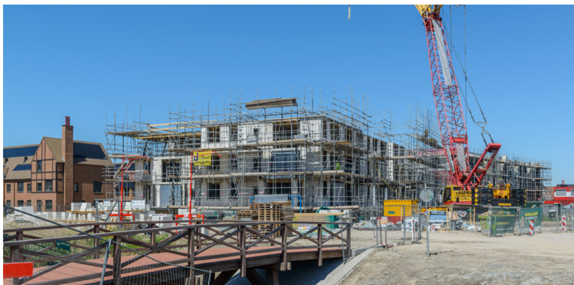
Afbeelding 3. Woningbouwproject Hoofddorp Hydepark en Tudorpark
