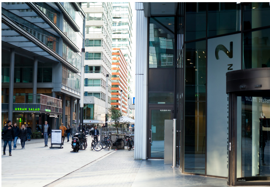
Afbeelding 4. Kantoren bij station Amsterdam Zuid
