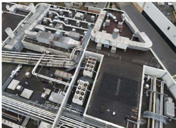
Toezicht Cargill vanuit de lucht
