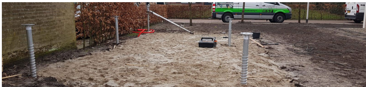
Afbeelding 6 | Elektrisch schroeffunderen
