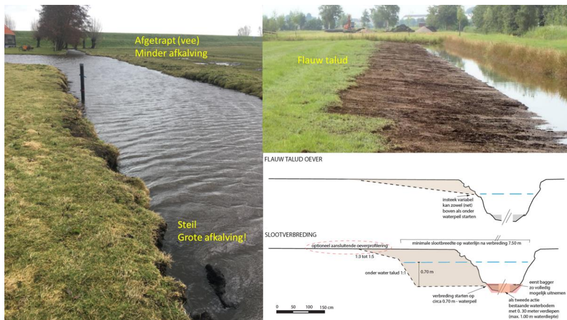
Afbeelding 5.7 Links de huidige situatie met steile oevers en veel afkalving en afgetrapte oevers (door vee) zonder oevervegetatie. Rechts de gewenste situatie met oevers met een flauw talud (beeld toont oever net na aanleg en zonder vegetatie). Op strategische locaties (aan de randen van Peereboom) kunnen ook slootverbredingen en/of plas-dras locaties worden aangelegd met het oog op vis / waterfauna
