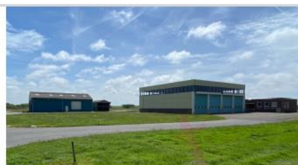
De huidige bebouwing van de voormalige werf van het HHNK vervaangen door woningbouw als 'echte' van Nieuw Petten aangevuld met een nieuw Gemeenlandshuis als blikzanger en koppelgebouw
