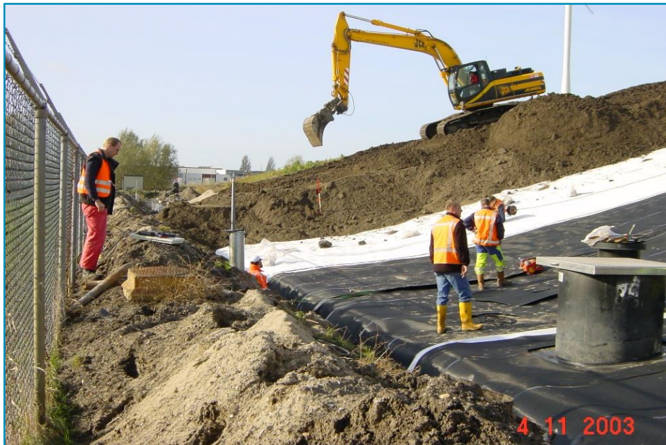
Foto met deepwell 21, geen kabel en leidingen boven de folie
