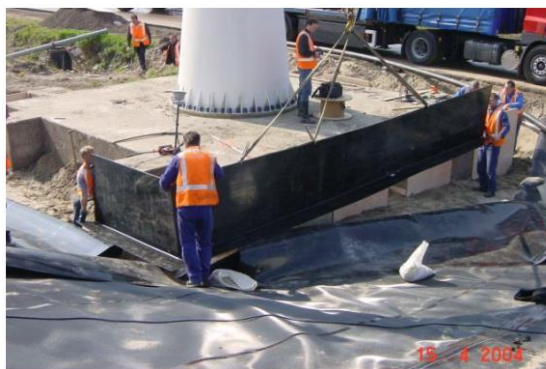
Bevestigen HDPE-platen rondom fundering windmolens
