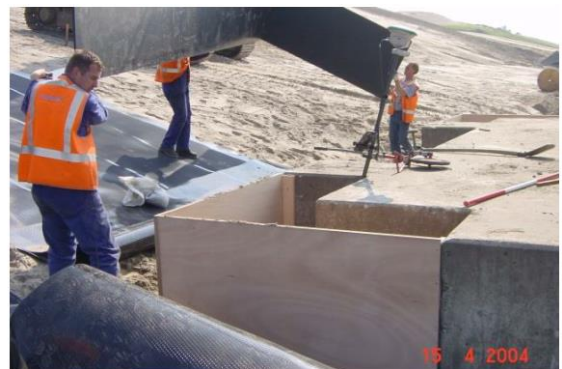
De binnenzijde werd later opgevuld met beton
