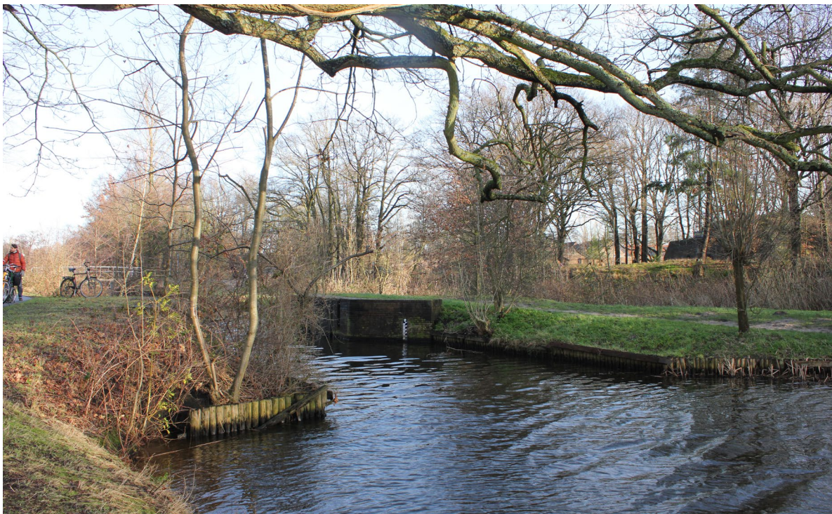
Damsluis in de Karnemelksloot met aan weerszijden de batterijen.
