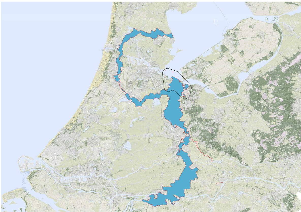
De begrenzing van het Unesco Werelderfgoed Hollandse Waterlinies en aanduiding van het deelgebied 'Vechtstreek Noord'. (NB. de begrenzing Unesco Werelderfgoed zal aan de zuidzijde van de Haarlemmermeerpolder rond de A4 nog wijzigen)
