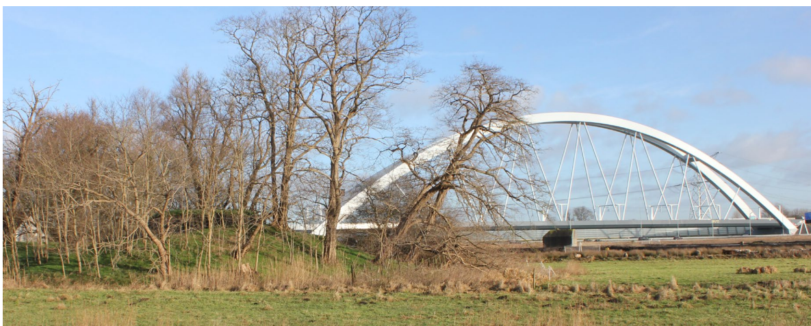
Kazemat tussen het groen en groepsschuilplaats bij de A1 en spoorbrug.
