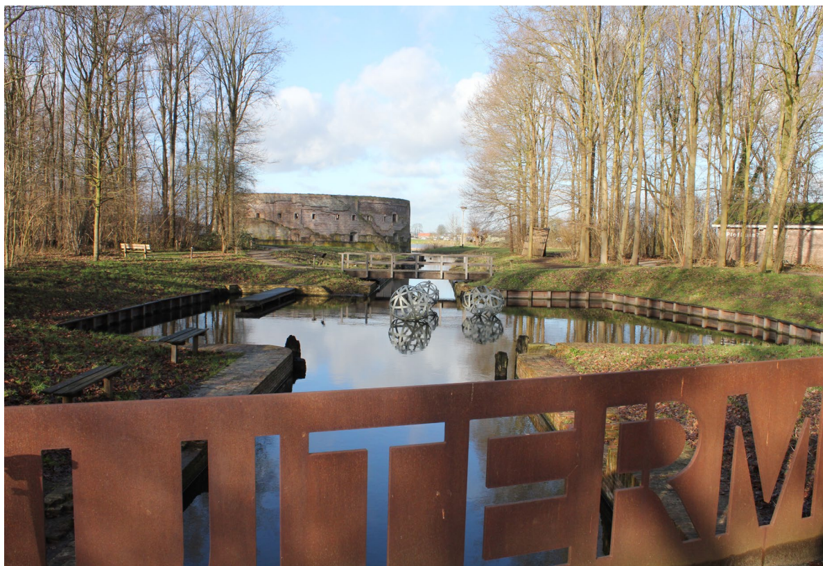
Inundatiesluis bij Fort Uitermeer.
