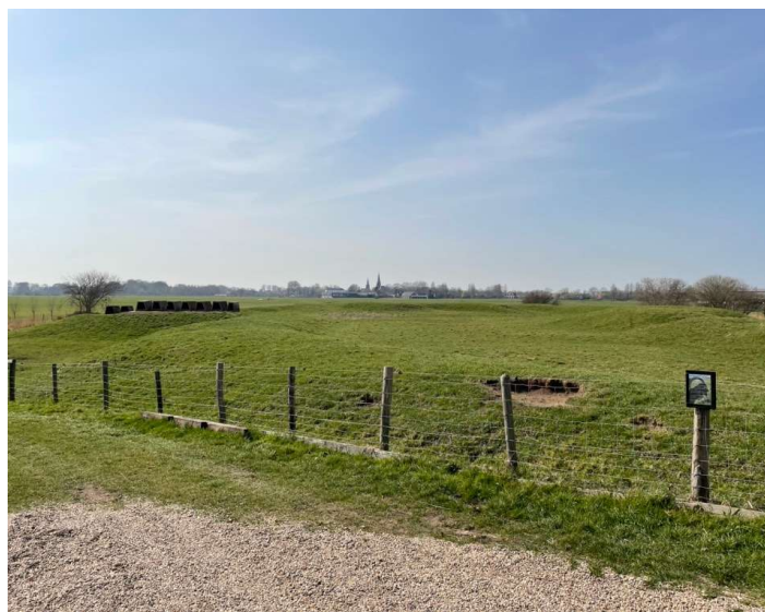
Foto van de Batterijen aan het Gein
