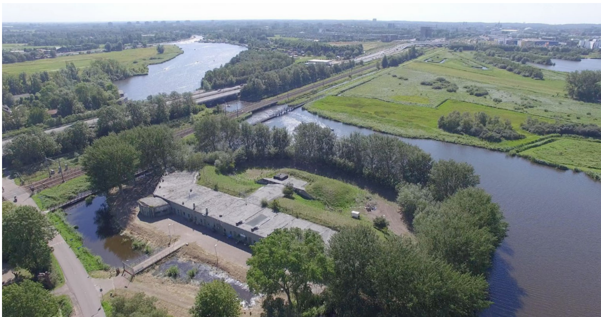
Acces trekvaart Haarlem-Amsterdam, provinciale weg en spoorlijn bij Fort aan de Liebrug (foto Hanno Lans, bron: https://www.stellingvanamsterdam.nl/nl/toolkit/fotos ).
