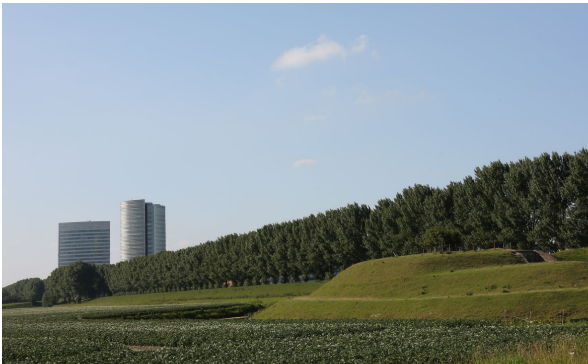
De Geniedijk bij Batterij aan de Sloterweg (foto Kenneth Stamp, bron: https://www.stellingvanamsterdam.nl/nl/toolkit/fotos ).
