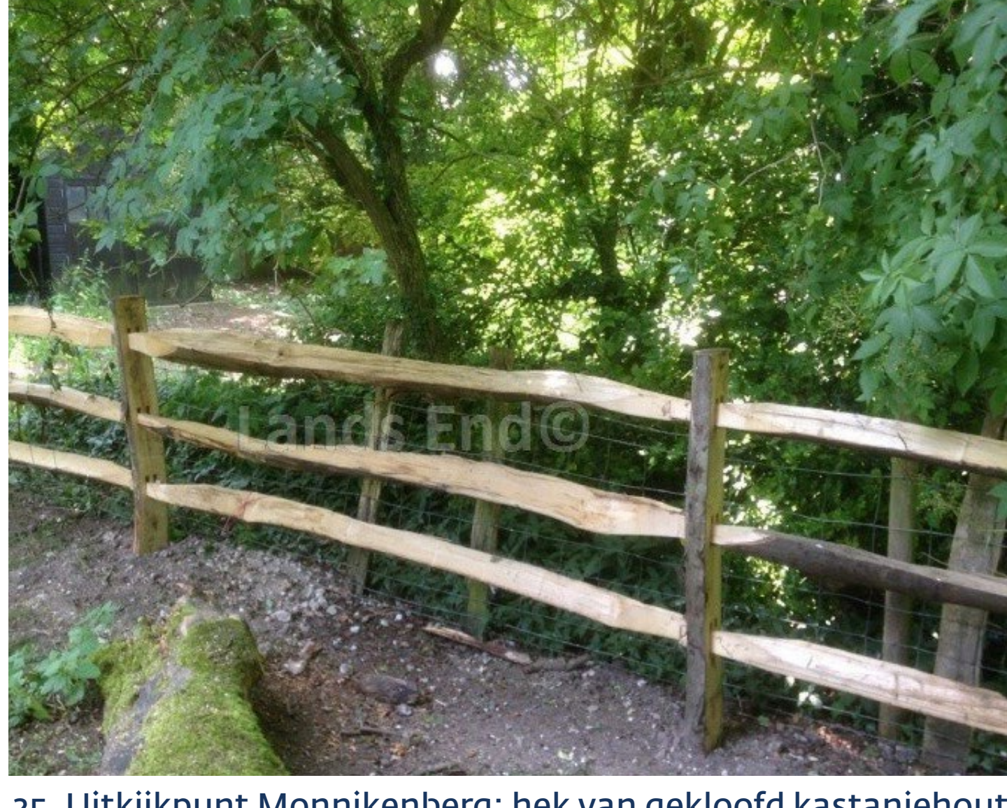
25. Uitzichtpunt Monnikenberg: hek van gekloofd kastanjehout als afscherming rustgebied en markering uitzichtpunt
