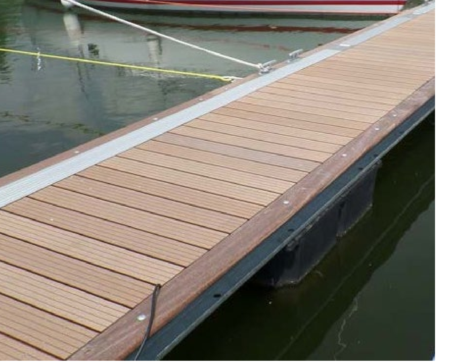
23. Vlonderpad bergvijver: drijvende vlonder zodat waterbeleving optimaal is en vlonder altijd toegankelijk
