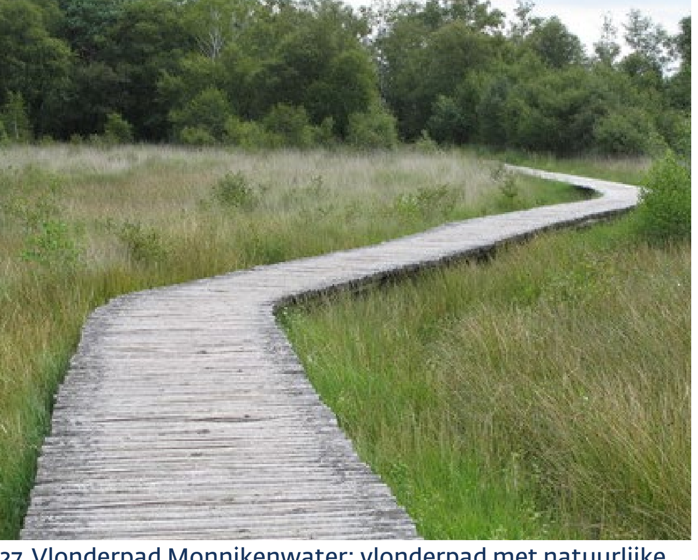
27. Vlonderpad Monnikenwater: vlonderpad met natuurlijke uistraling, zonder leuning. Pad ligt vlak boven het maaiveld.
