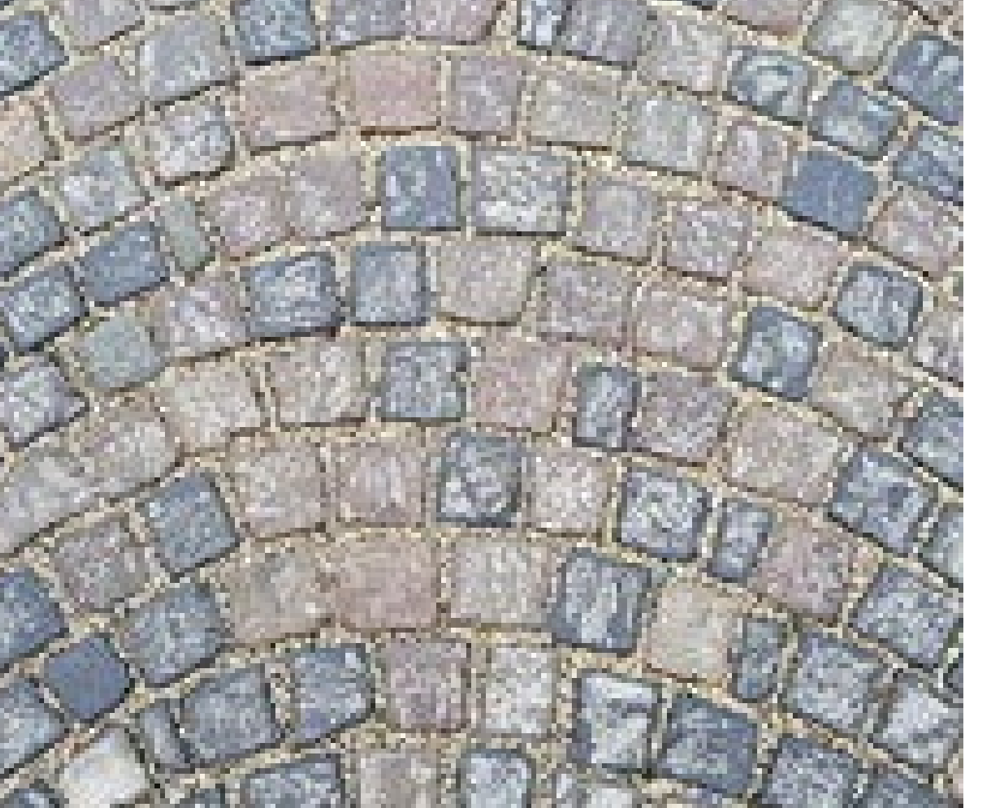
25. Uitzichtpunt Monnikenberg: vloer van granietkeitjes rond bank voor comfort en tegen erosie.
