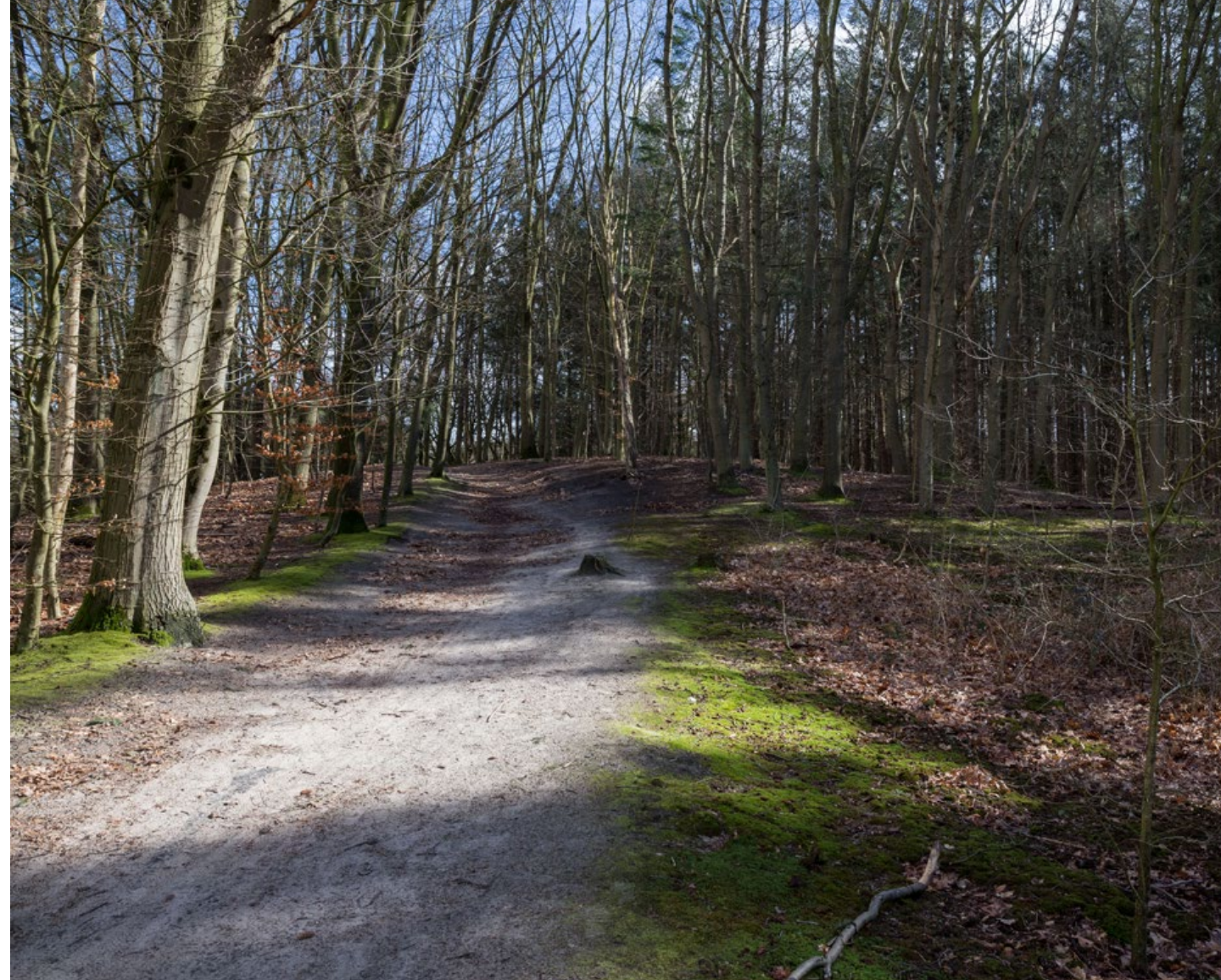
22/28. Verleggen wandelpaden Anna's Hoes en Monnikenberg. Zandpaden worden omgelegd met zelfde maat.
