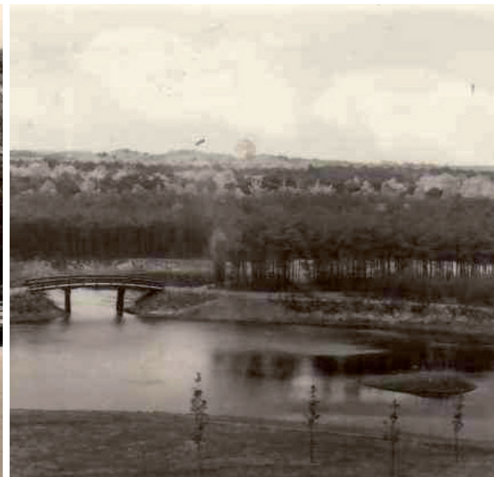
Zicht vanaf de belvédère vlak na aanleg
