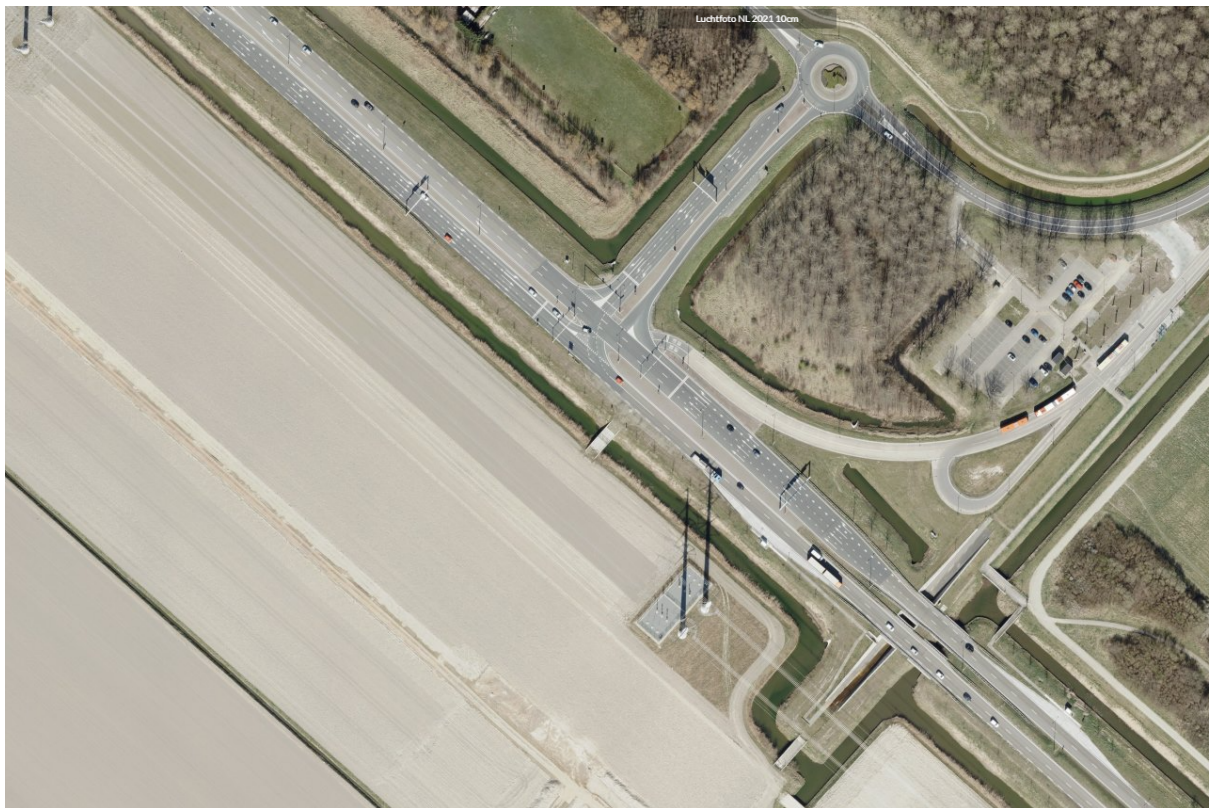
Figuur 2-5: Luchtfoto van de bestaande situatie nabij P&R Getsewoud in Nieuw-Vennep, met in het zuiden de bestaande fietstunnel en fietsbrug.
