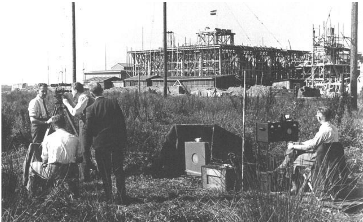
Figuur 8. NERA gebouw in aanbouw, ca. 1949. Op de voorgrond is de ruige begroeiing van het drassige terrein duidelijk te zien.
