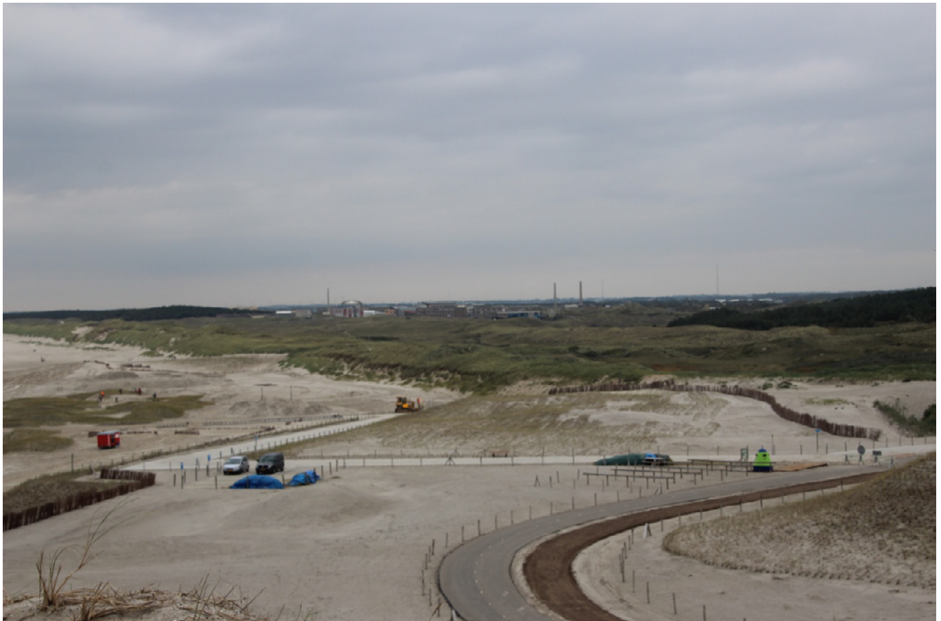
Werkzaamheden in het kader van de zwakke schakel bij Petten, met op de achtergrond de onderzoekslocatie Petten.
