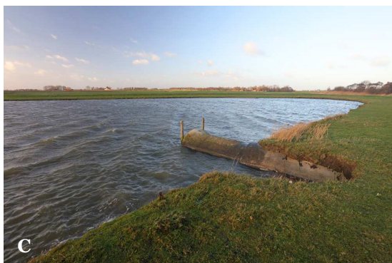
Figuur 2A t/m 2C: onderscheiden NVO-type: A) Over de hele lengte breed aangetakt aan het kanaal, B) open verbinding met kanaal via smalle doorgang van circa 8 meter breed (zie rode pijl), C) open verbinding via twee duikers.
