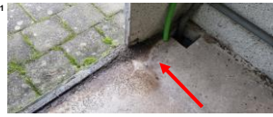
Elektragebouw (oude situatie)
