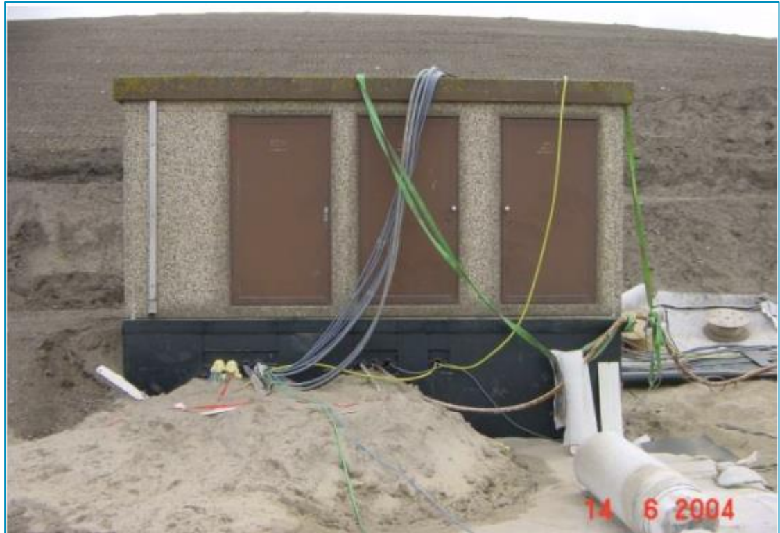
HDPE-plaat ter plaatse van verdeelstations
