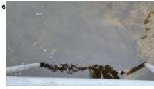
Uitstroopening hemelwaterdrainage
