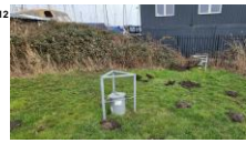
Werkzaamheden nabij reddingsbrigade
