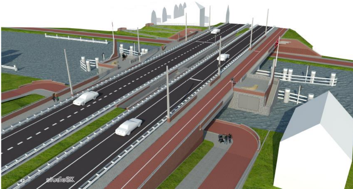
Afbeelding: ontwerp brug met aan weerszijden de twee technische ruimten op de voorgrond (bron: studioSK)
