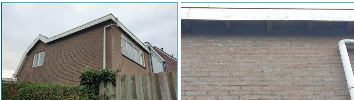
Figuur 4-2. De zuid- en oostzijde van Hillegommerdijk 55, met de dakrand met overstek en stootvoegen die de vleermuizen toegang geven tot de spouw. Foto's: RHDHV, 2020.
