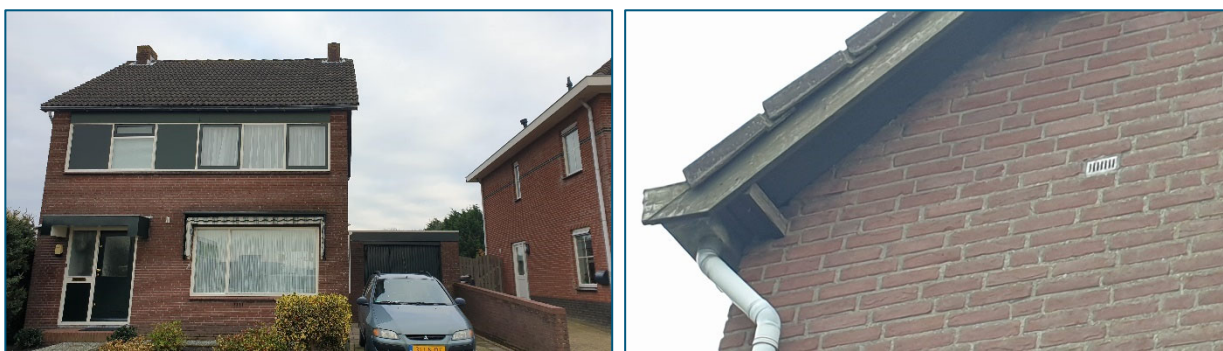
Figuur 4-3. De west- en zuidzijde van Hillegommerdijk 52, met de opening net boven de gording stootvoegen die de vleermuizen toegang geven tot de spouw en het dak. Foto's: RHDHV, 2020.
