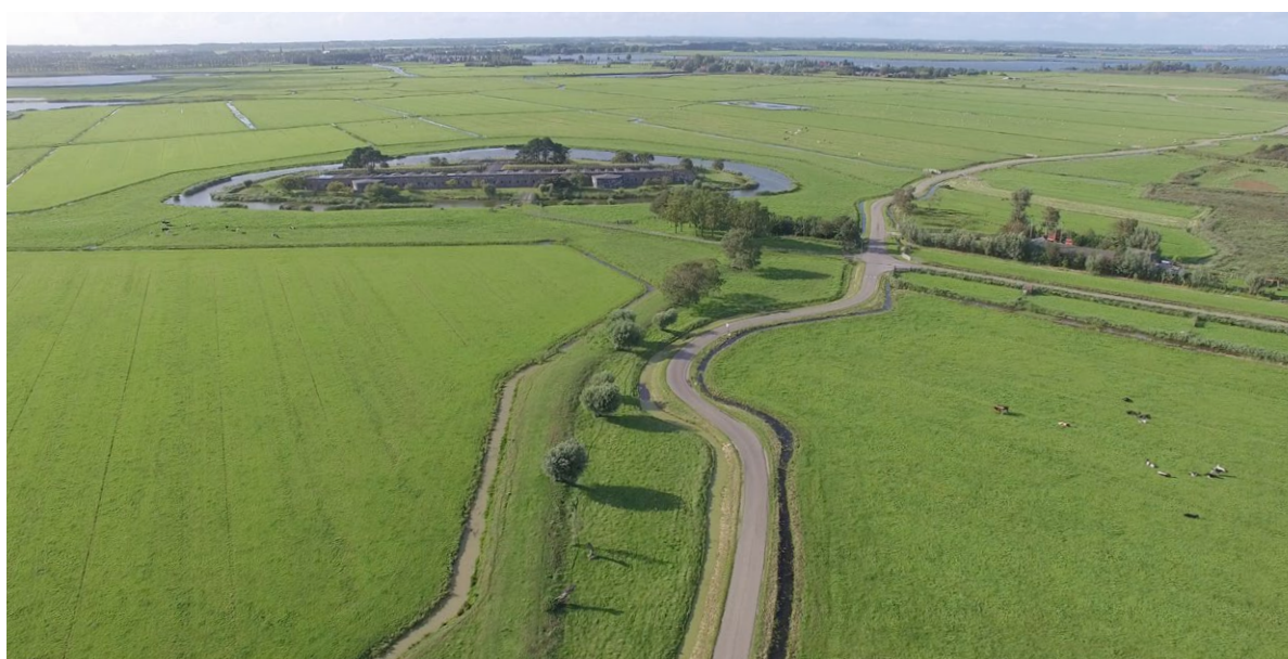
Liniewal/inundatiekaede richting Fort bij Krommeniedijk. (foto Hanno Lans, bron: https://www.stellingvanamsterdam.nl/nl/toolkit/fotos ).
