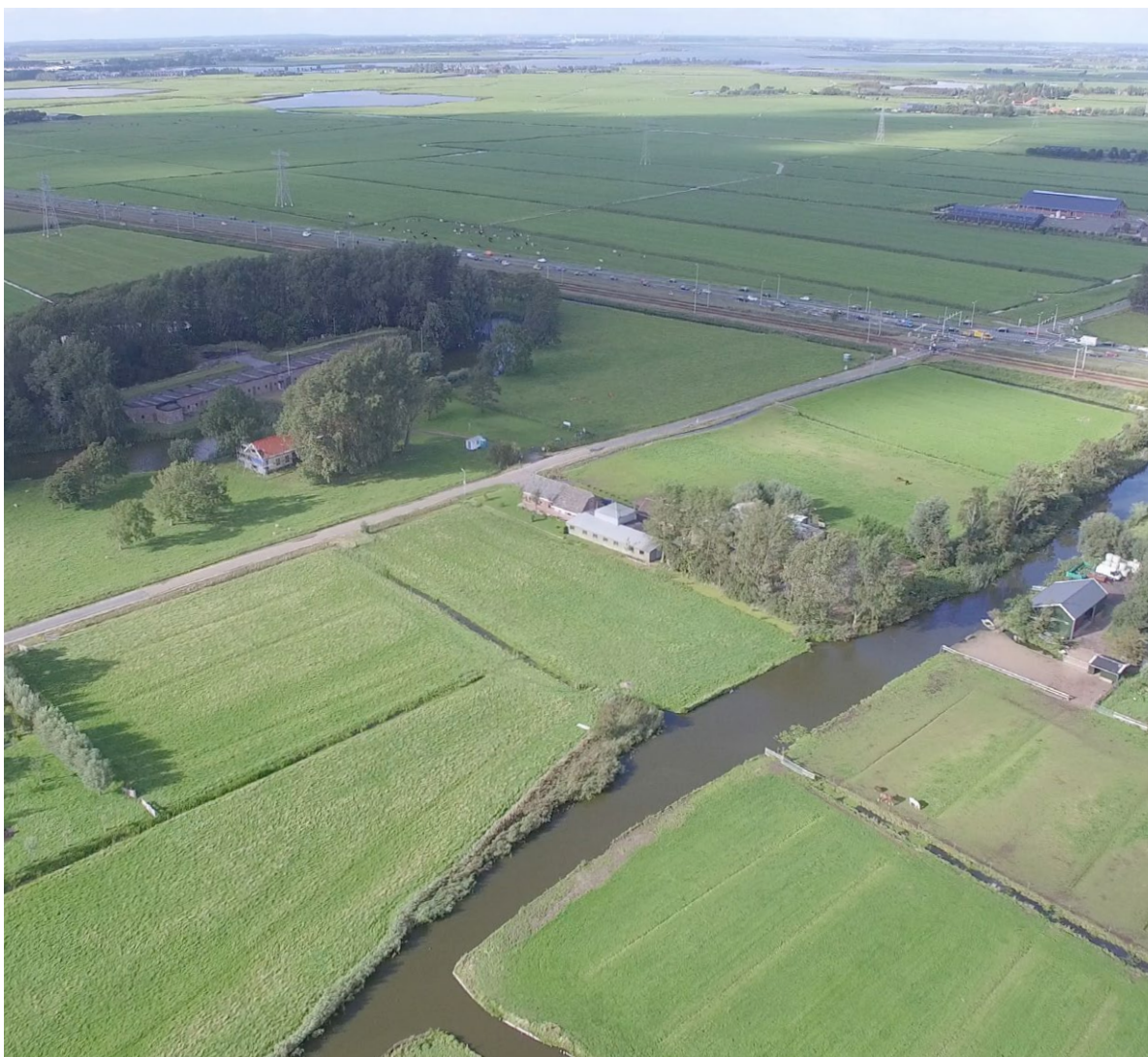
Fort aan De Ham bewaakt het acces van de spoorweg tussen Assendelft en Uitgeest (foto Hanno Lans, bron: https://www.stellingvanamsterdam.nl/nl/toolkit/fotos ).
