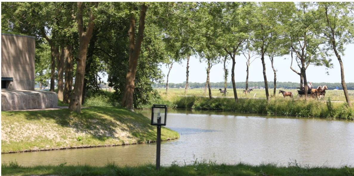
Contrast tussen fort en raster van de Beemster; doorzicht van achter Fort aan de Nekkerweg over de Nekkerweg (foto Kenneth Stamp, bron: https://www.stellingvanamsterdam.nl/nl/toolkit/fotos ).
