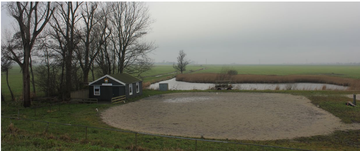
De opvangkom van de inlaatsluis in de Starnmeer.
