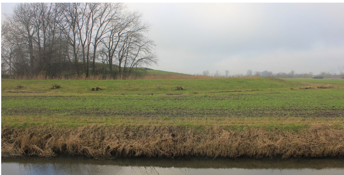
Glooiende wallen van het fort aan de Middenweg in het vlakke en orthogonaal opgebouwde Beemster.
