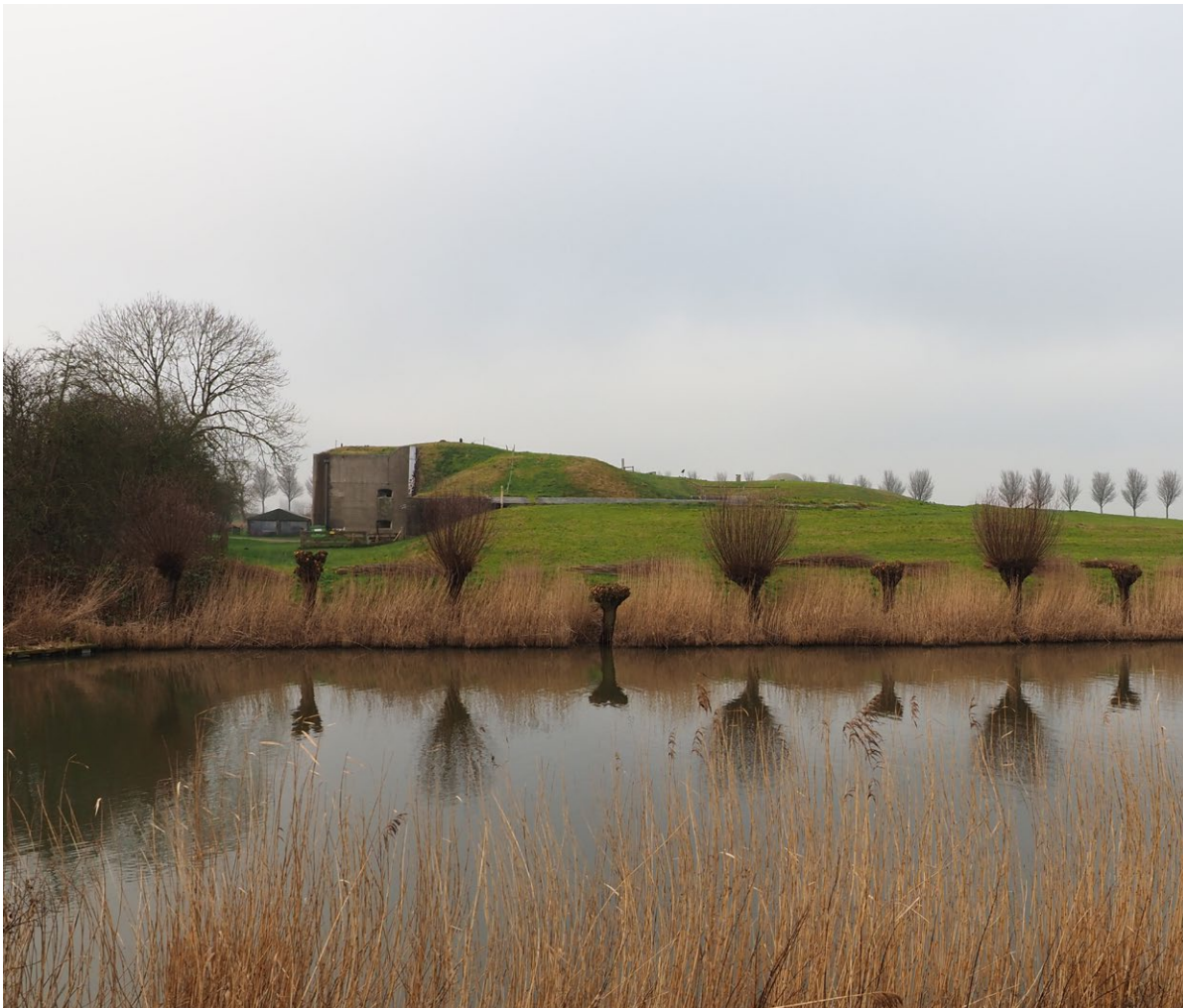
Fort bij Spijkerboor: beplant aan de Keelzijde, 2 verdiepingen hoog hoofdgebouw en beplante frontwal.
