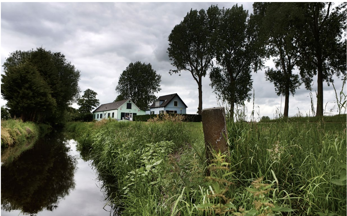
Fortwachterswoning en bergloods met grens paal van Fort bij Kwadijk (foto Kenneth Stamp, bron: https://www.stellingvanamsterdam.nl/nl/toolkit/fotos ).
