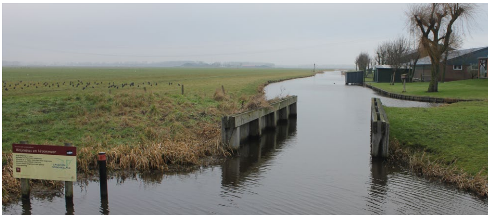
Beschoeide doorvaart in de liniewal/inudatiekade in de Overtoomsloot.
