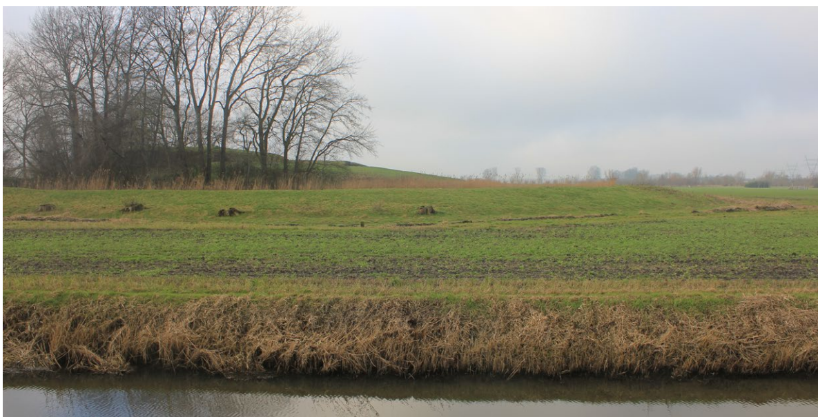
Glooiende wallen van het fort aan de Middenweg in het vlakke en orthogonaal opgebouwde Beemster.
