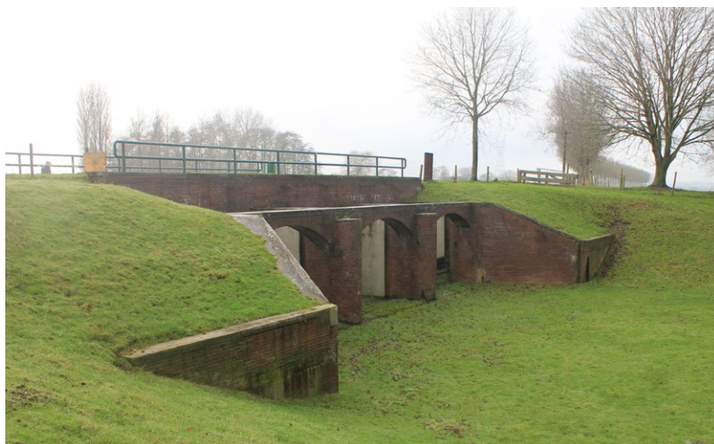
Inlaatsluis in de Beemsterringdijk, ingang aan de ringvaart en uitgang in de opvangkom. De sluis is aan het eind van de tweede wereldoorlog open gezet door de Duitsers (Bron: www.laagholland.com )
