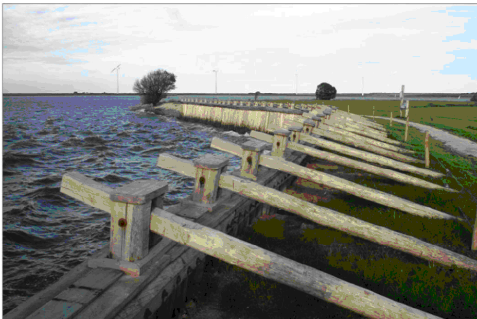
Figuur 3.4 Reconstructie van een palendijk langs het Eemmeer bij Spakenburg. Tot de paalworm epidemie van 1734 werd de gehele zuiderzeekust op deze wijze beschermd. Tegenwoordig vormt de paalworm geen probleem meer omdat deze alleen in zout en brak water leeft.
