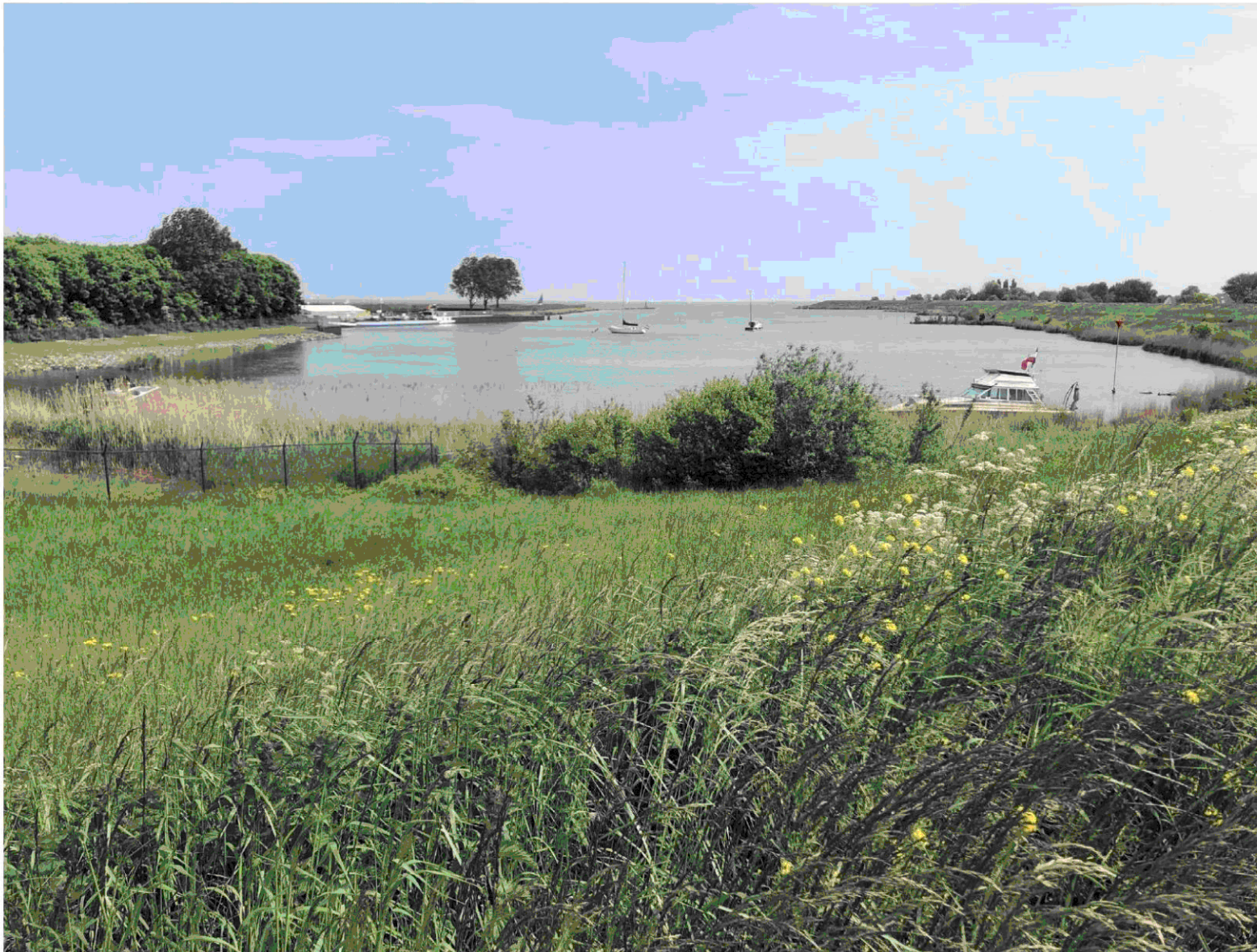
Zicht op de baai bij Oosterdijk met links de werkhaven en rechts de Westfriese Omringdijk
