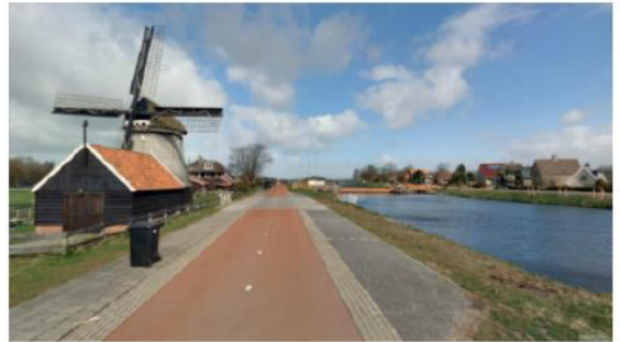
Molien en pontanbrug over het Noord-Hollandskanaal
