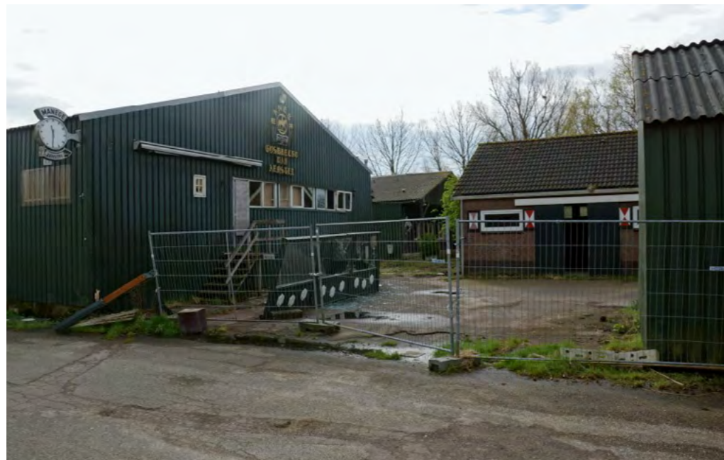
stallencomplex van de voormalige manege
