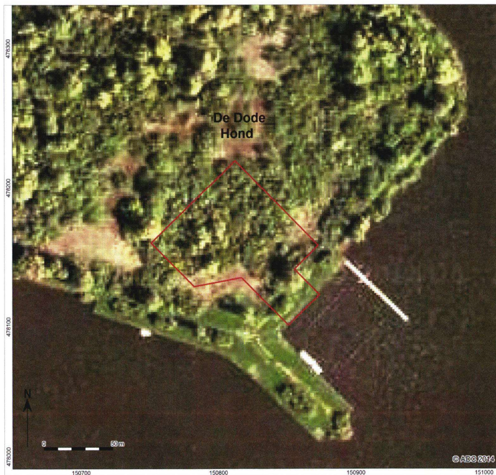
Afbeelding 3: Het zuidoostelijke deel van het eiland met het bestaande uitpandige haventje. Het rood afgebakende vak is het plangebied waarin het inpandige haventje wordt aangelegd. (onderliggende kaart is afkomstig van Google Maps).
