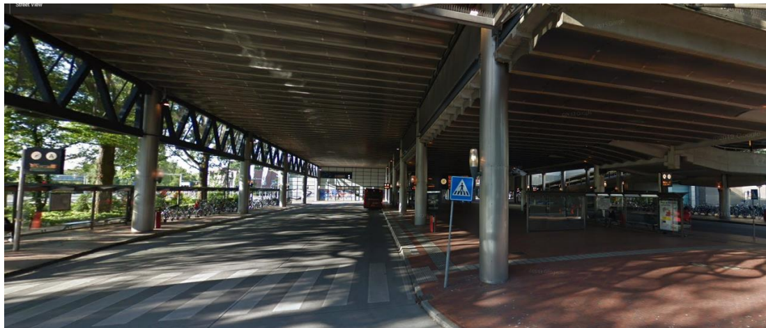
Figuur. Op busstation Amstelveen zijn fietsenstallingen, voorzieningen en droge wachtruimtes beschikbaar. De transferveiligheid is hier goed met een middenperron. De sociale veiligheid en aantrekkelijkheid van het busstation is echter een aandachtspunt.
