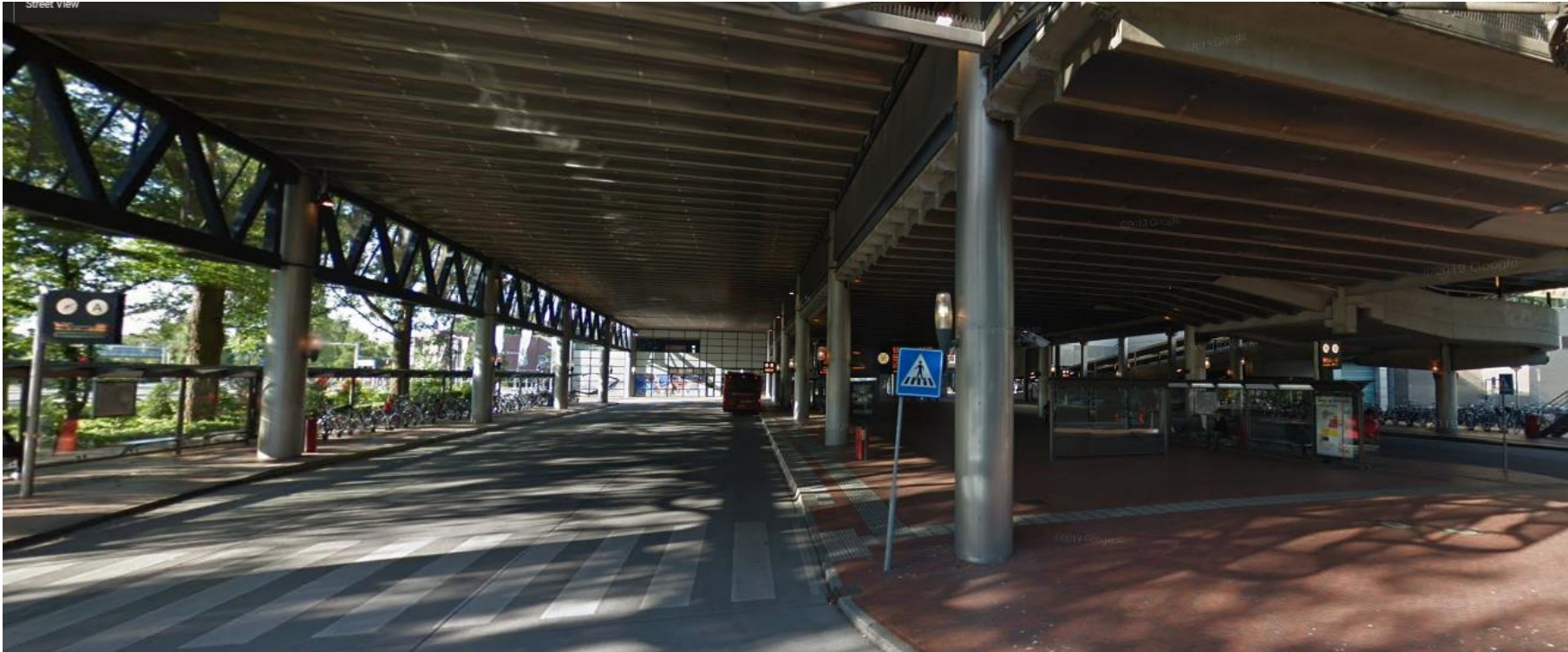
Figuur. Op busstation Amstelveen zijn fietsenstallingen, voorzieningen en droge wachtruimtes beschikbaar. De sociale veiligheid en aantrekkelijkheid van het busstation is echter een aandachtspunt.
