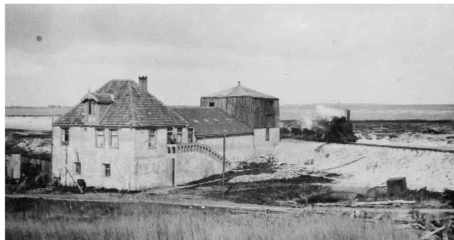
Graven klei put t.b.v. dijkherstel na de stormramp van 1916.
