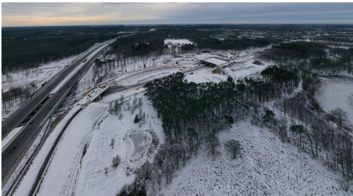
Foto 6: natuurbrug, fly-over en busbaan in de sneeuw (foto: Bouwfilm.nl)
