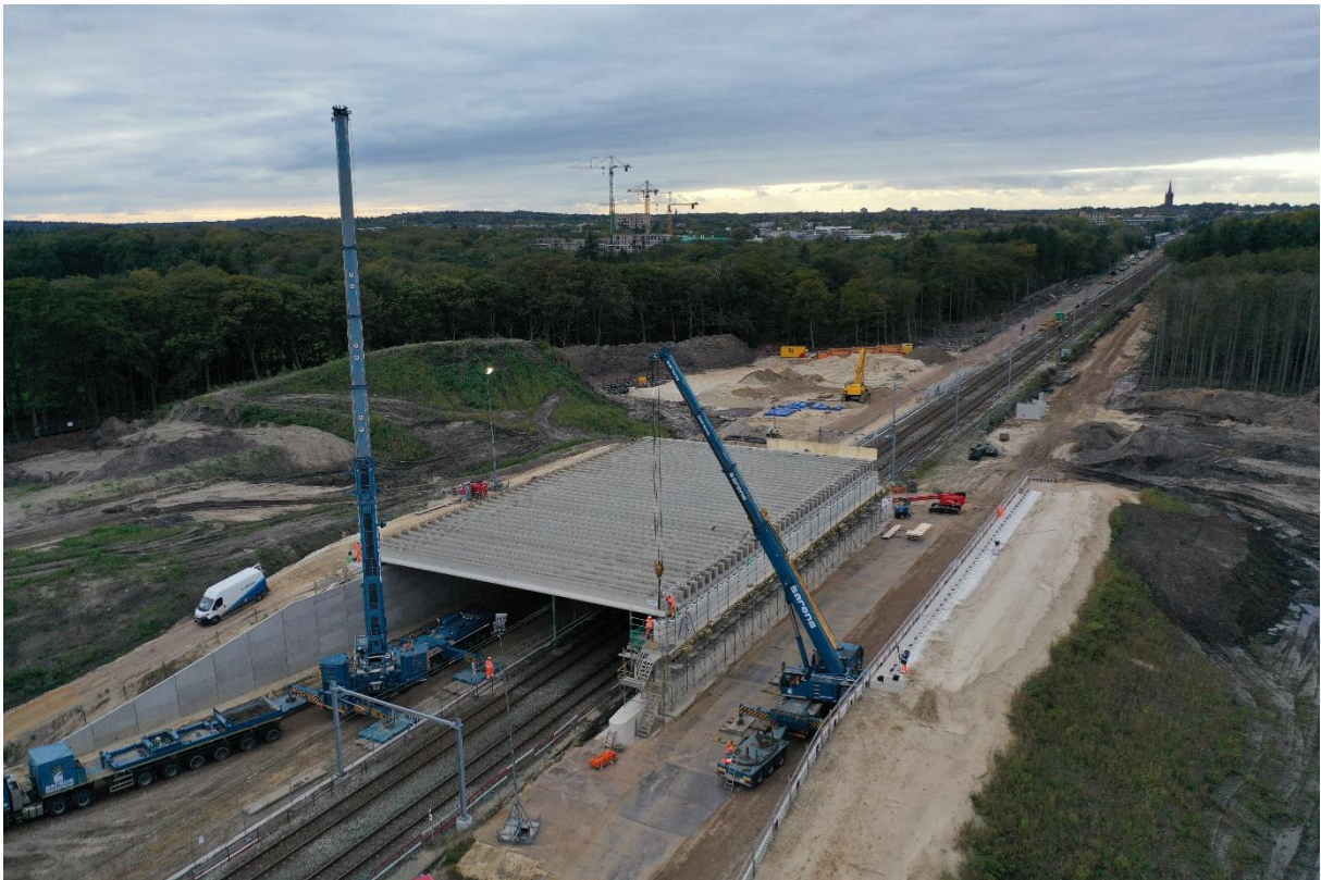
Foto 4: plaatsen liggers natuurbrug (foto: Bouwfilm.nl)
