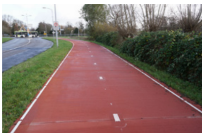
Gerealiseerd fietspad met gekoppelde betonplaten, Venneweg Hoorn
