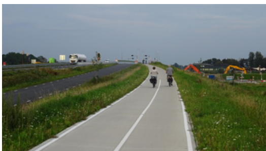
HWFR Hanzepad: viaduct
