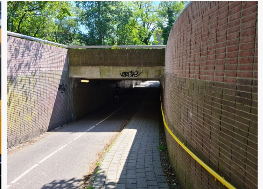
Onderdoorgang bij station Bloemendaal
