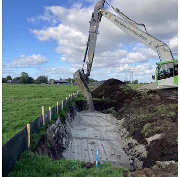
Het aanleggen van een duiker in Waterlandtak-Oost
