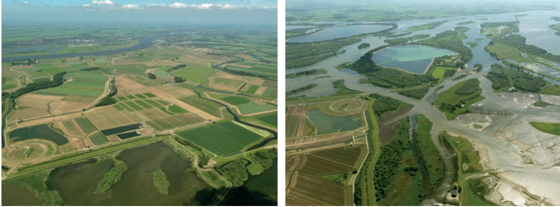
TenneT station in Noordwaard polder bij laag water (links) en hoog water (rechts). Bron: Rijkswaterstaat
