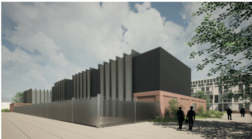
Transformatorstation bij een nieuwe woonwijk. OS IJburg. Bron: Alliander
