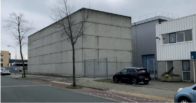
Transformatorstations in bedrijventerrein, Waardepolder
