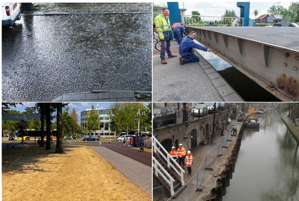
Figuur 2: Voorbeelden van verschillende klimaateffecten op verschillende typen infrastructuur (van rechtsboven met de klok mee; water op straat door extreme neerslag, problemen bij beweegbare bruggen door hitte, verzakte kades door droogte/bodemdaling en uitgedroogde bermen door droogte).
