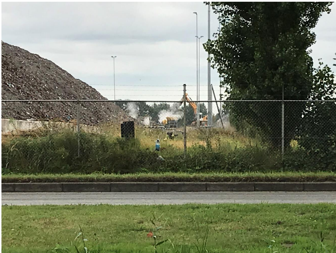
Foto 1: De bodemas wordt in een opwerkingsinstallatie gestort, foto van 25 augustus 2020
